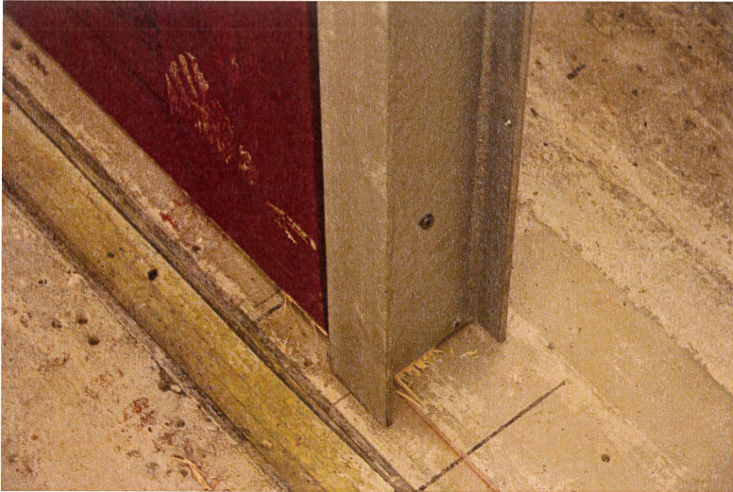
Bild 3 – En av stolparna, I-balk.
