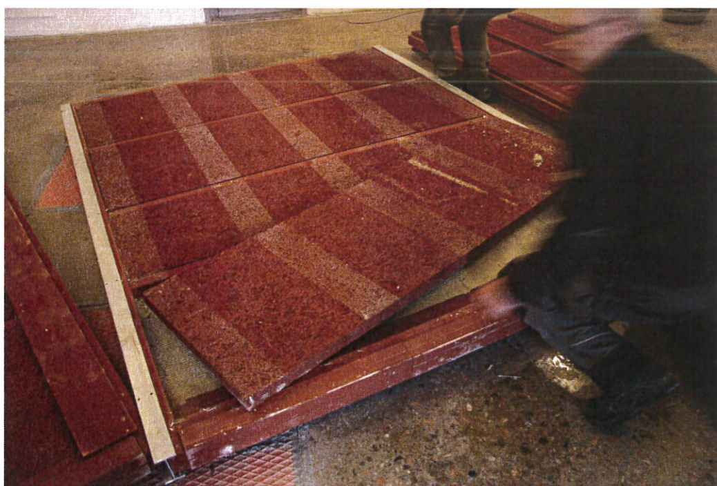
Bild 10 – Skärmen under demontering, 50 mm träullsskivor tas bort.
