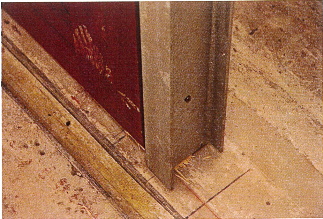
Bild 3 – En av stolparna, I-balk.. Bild från ljudisoleringsmätning.
