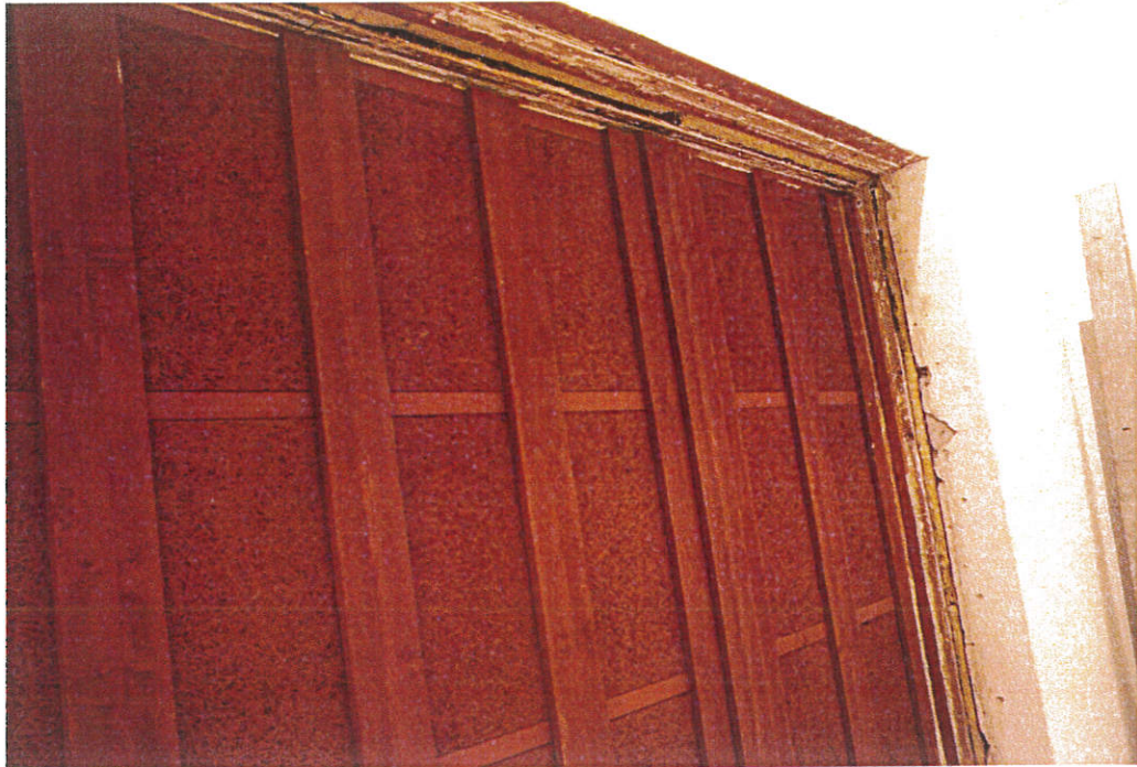
Bild 7 – Skärmens trafikside. Bild från ljudisoleringsmätning.
