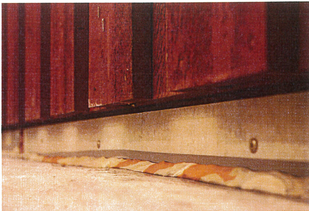
Bild 5 – Skärmens underkant, ej trafiksidan. Bild från ljudisoleringsmätning.
