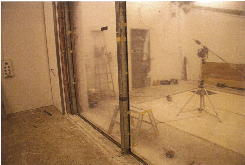
Bild 2 – Provobjektet sett från sändarrummet.
